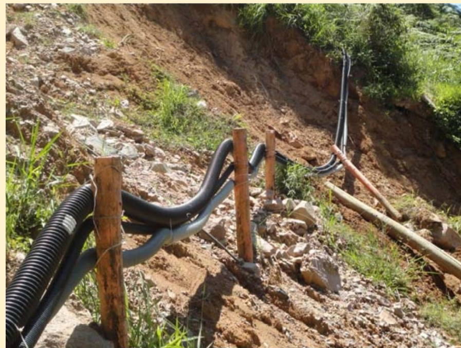
tubulação reconstruída provisoriamente
